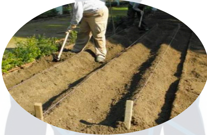
Preparar el terreno
